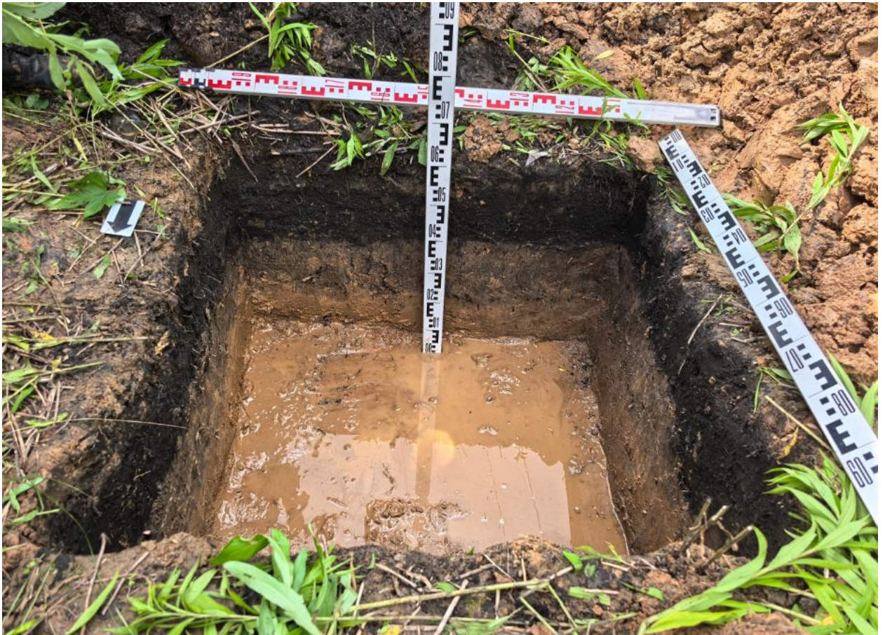
Илл. 14. «Газопровод-ввод к жилому дому (...)». Шурф 1. Прокопка и зачистка материка. Вид с С.
