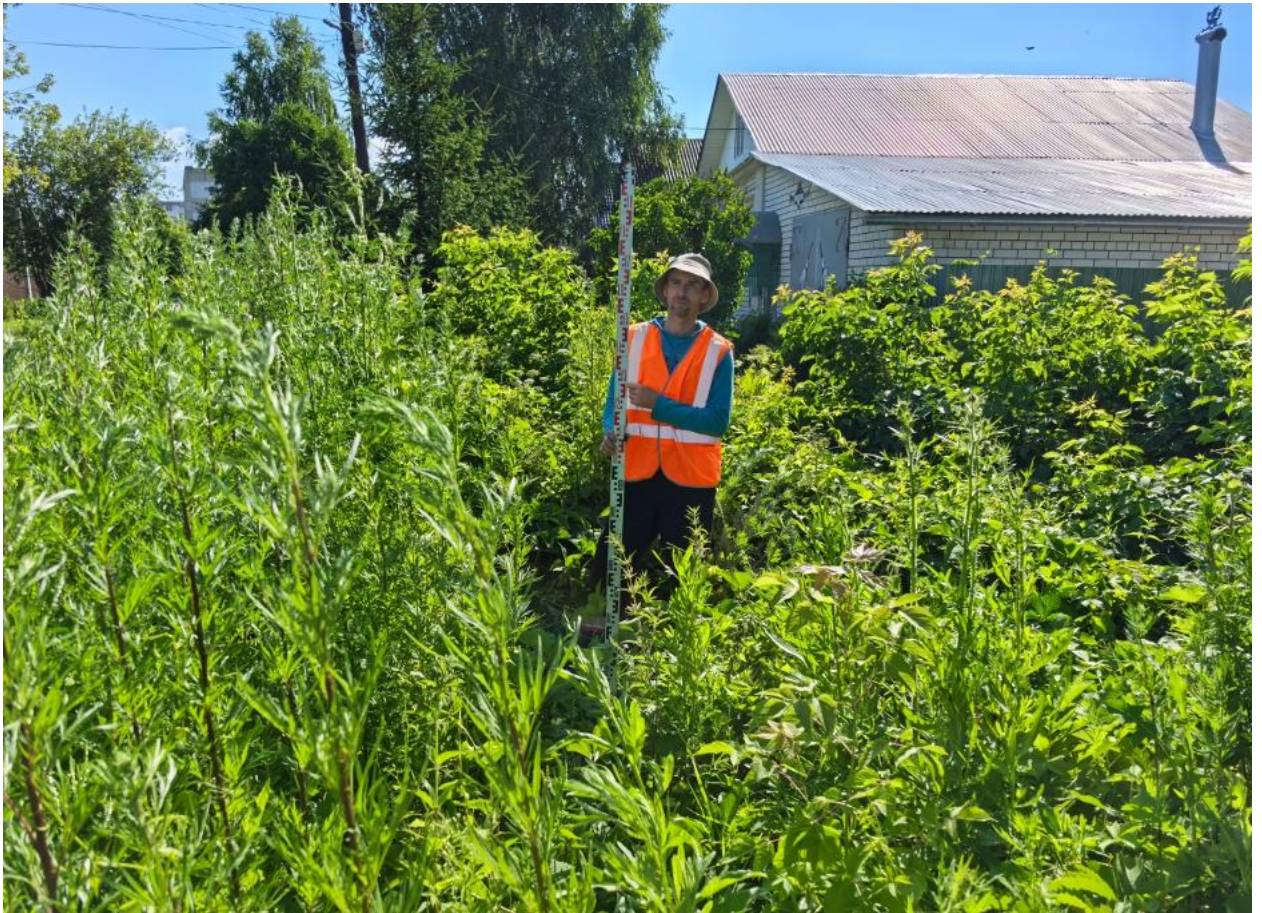
Илл. 16. «Газопровод-ввод к жилому дому (...)». Шурф 2 до начала работ. Вид с 3.
