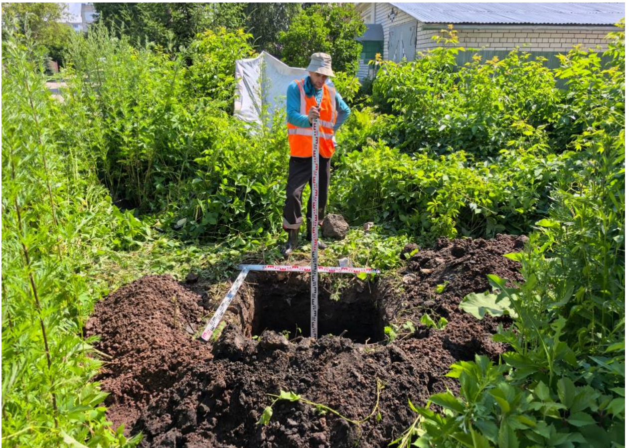
Илл. 17. «Газопровод-ввод к жилому дому (...)». Раскопанный Шурф 2. Вид с 3.
