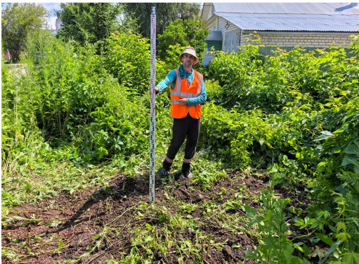
Илл. 19. «Газопровод-ввод к жилому дому (...)». Шурф 2. Рекультивация. Вид с 3.
