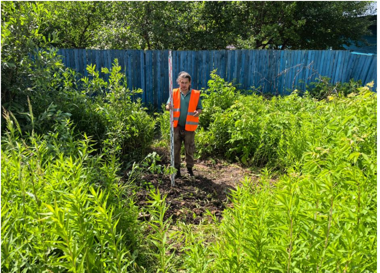
Илл. 15. «Газопровод-ввод к жилому дому (...)». Шурф 1. Рекультивация. Вид с С.
