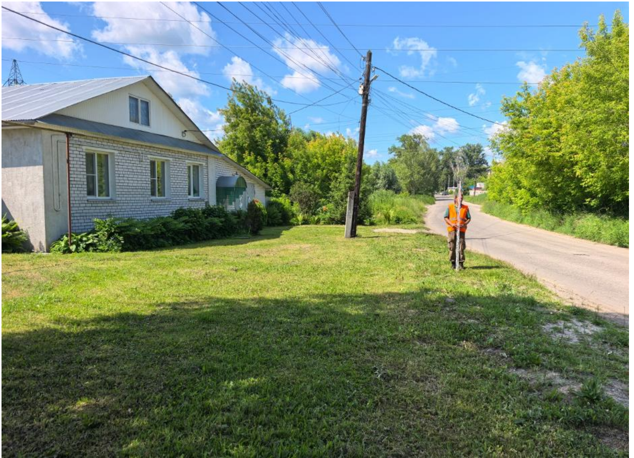
Илл. 10. «Газопровод-ввод к жилому дому (...)». Точка фотофиксации 3. Вид с ВСВ.
