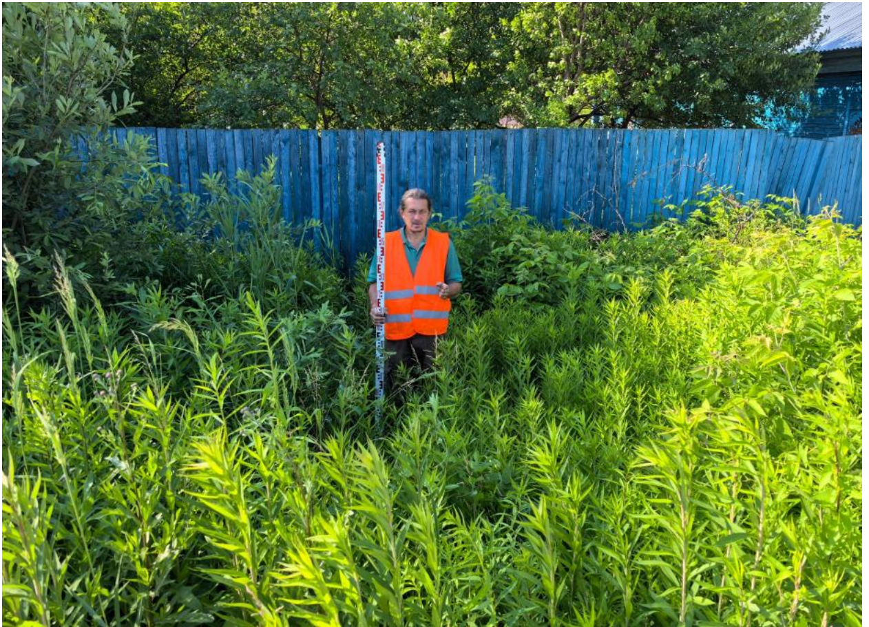
Илл. 12. «Газопровод-ввод к жилому дому (...)». Шурф 1 до начала работ. Вид с С.
