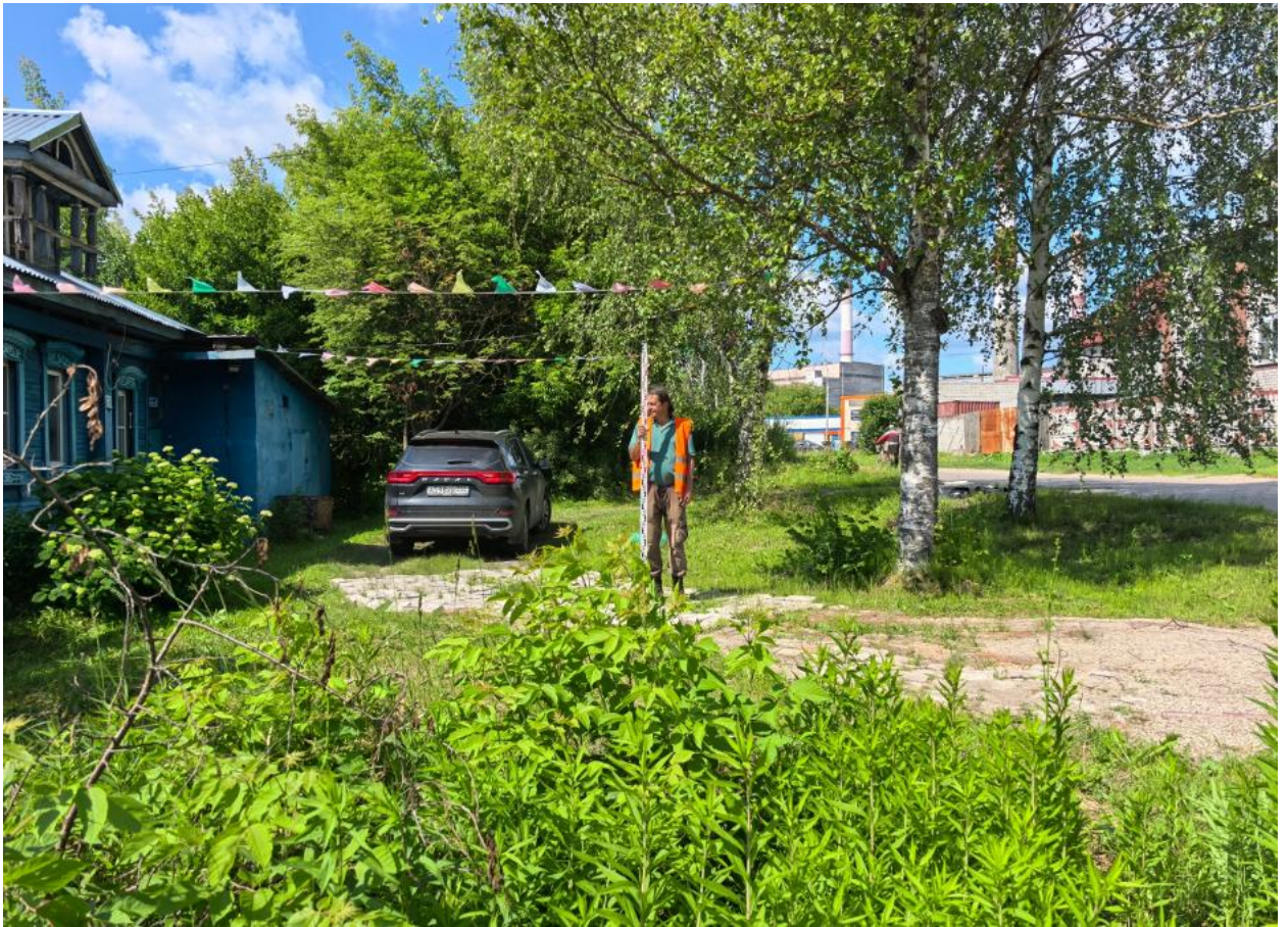
Илл. 6. «Газопровод-ввод к жилому дому (...)». Точка фотофиксации 1. Вид с ВСВ.
