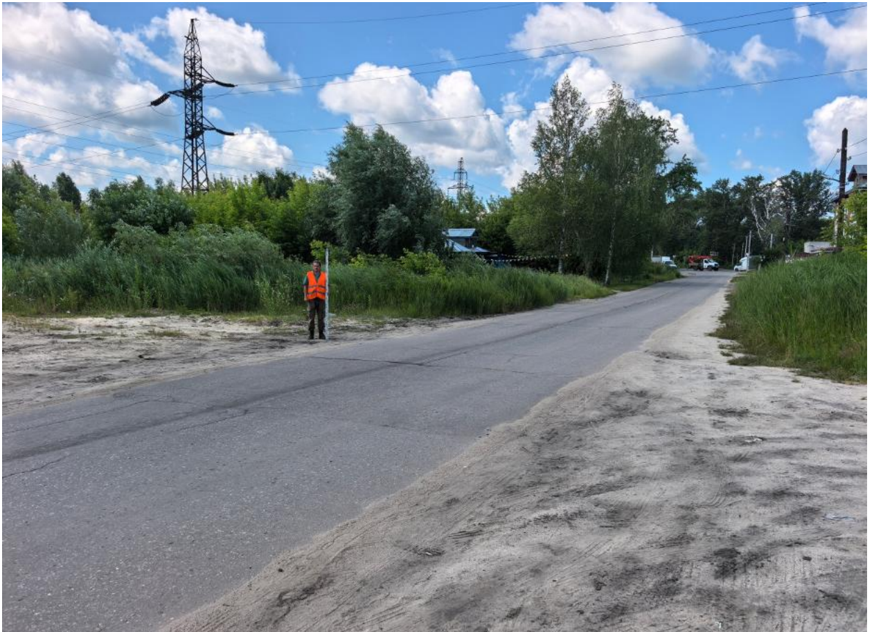
Илл. 8. «Газопровод-ввод к жилому дому (...)». Точка фотофиксации 2. Вид с ВСВ.
